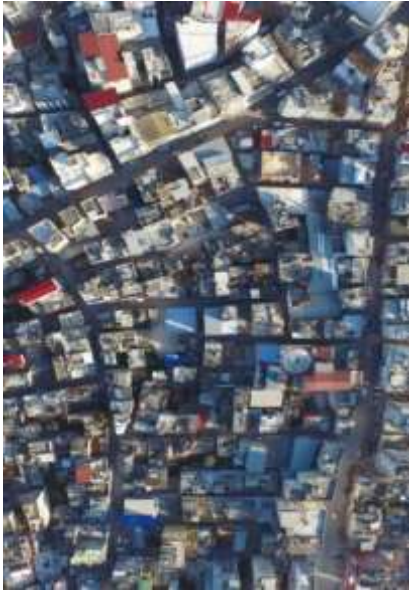
Kentsel dönüşüm öncesi alanın tepeden görünümü (Seyhan Belediyesi)
